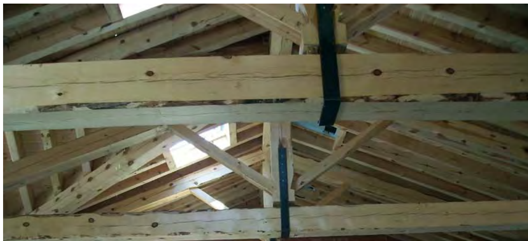
Figura 8.8. Estructura de madera en una vivienda
