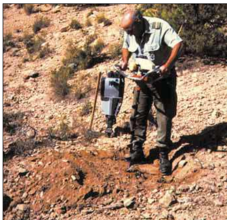
Apertura de hoyos con barrena mecánica, manejada por un sólo hombre. Tras la preparación de una pequeña plataforma con la azada se hace un hoyo con barrena que profundiza 50-60 cm
