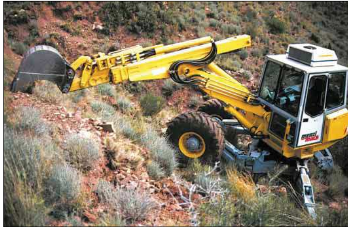
Apertura de hoyos por retroexcavadora. La maniobrabilidad de la máquina permite usarla en terrenos accidentados y su potencia permite abrir hoyos de gran tamaño que a veces son necesarios para asegurar el desarrollo de las plantas
